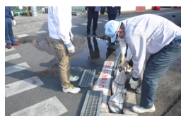
土のうで堰き止め処置
