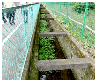
敷地境界北側の様子
